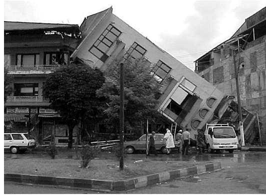
a) Volcamiento por licuación en Japón, 1964. b) Volcamiento en Turquía por falla en cimentación.
