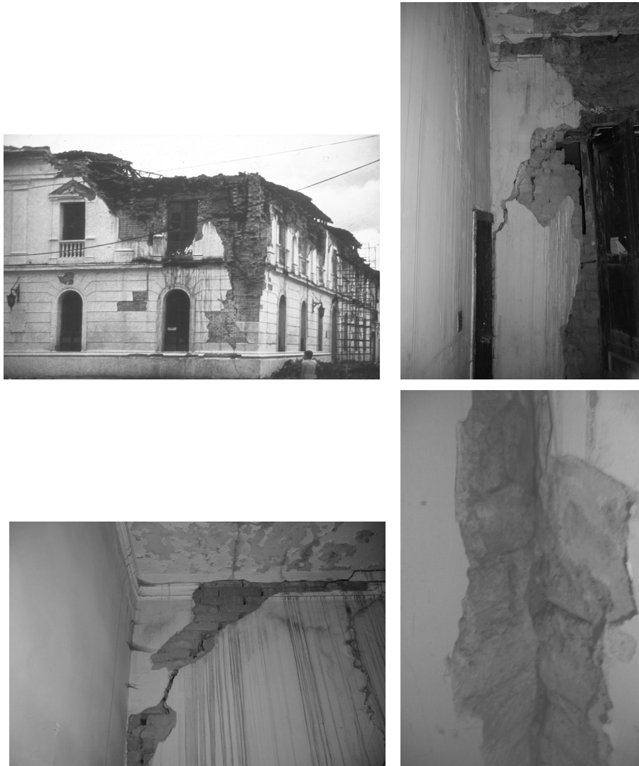
Fotografías A.3-1. Daños en muros de tapia
