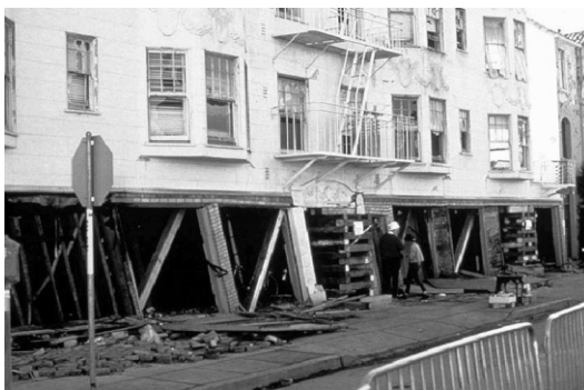
Fotografía 4-1. Inestabilidad estructural por falta de arriostramiento
