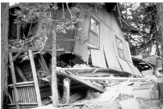
a) Resistencia inadecuada muros primer piso
