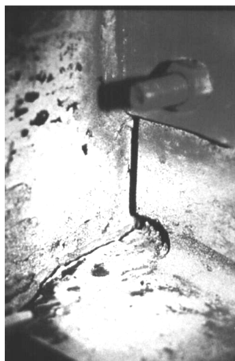
b) Falla de soldadura en pórticos no arriostrados
