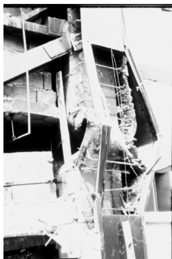
a) Pandeo de columna en pórticos arriostrados
