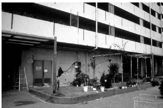
Fotografía 4-9. Muros fallados por cortante, Kobe, 1995
