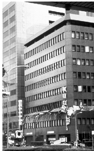
Fotografía 4-7. Pérdida de piso en un edificio en Kobe, 1995
