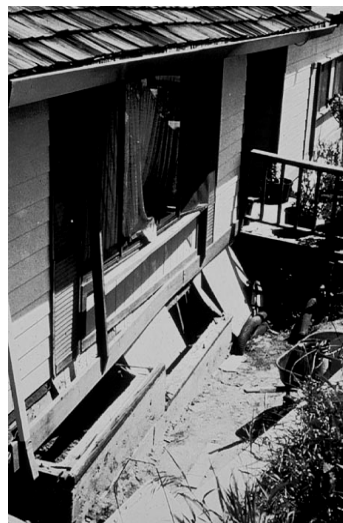
d) Desplazamiento de la base
