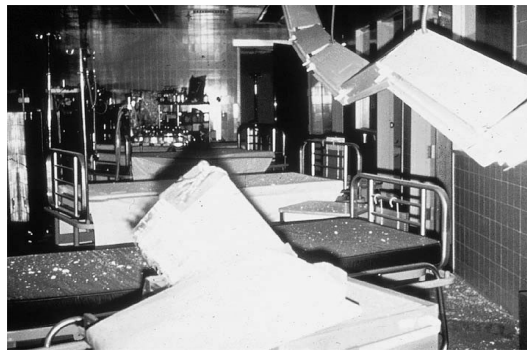
Fotografía 5-3. Caída de cielorraso muy pesados y con anclaje deficiente
