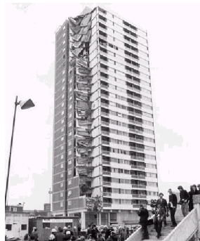
Fotografía 4-5. Colapso progresivo en el edificio Ronan Point, en Londres, 1968.
