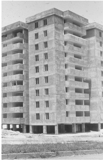
Fotografía 2-2. Piso débil en la primera planta
