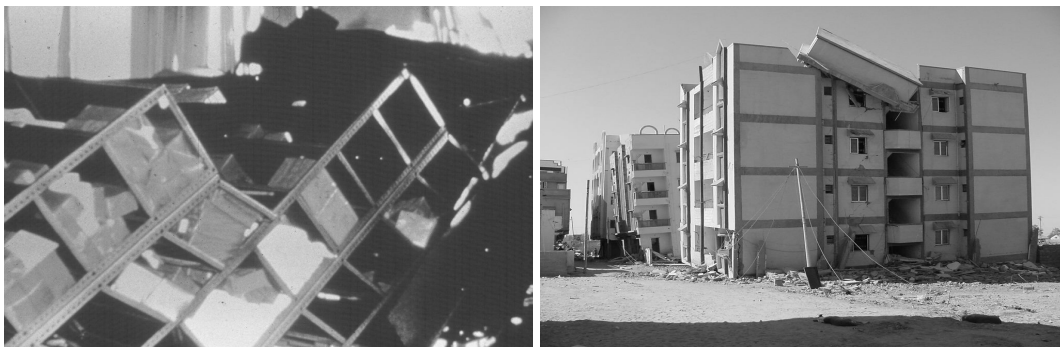
Fotografía 5-4. Ejemplos de volcamiento
