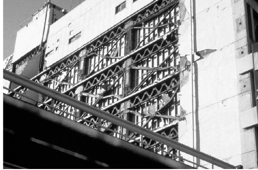
Fotografía 4-8. Pandeo de riostras en pórtico de acero. Kobe, 1995.
