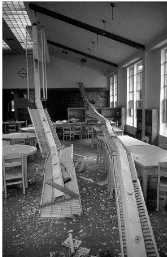
Fotografía 5-6. Ejemplos de daño por vaivén o balanceo
