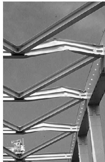
a) Columna de concreto, Méjico 1985 b) Riostras de acero, Kobe, 1995
