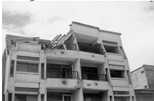
Fotografía 2-3. Daños en antepechos y fachada de la edificación
