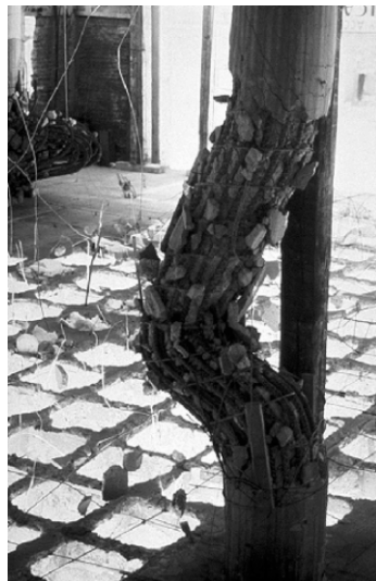
a) Columna de concreto, Méjico 1985 b) Riostras de acero, Kobe, 1995
