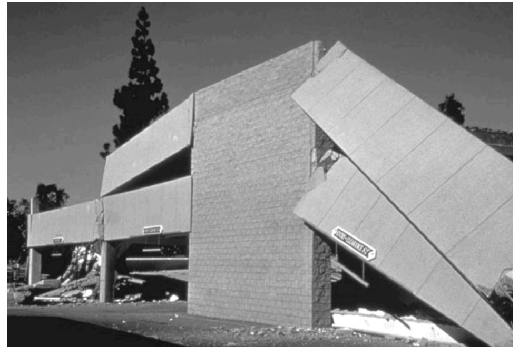
Fotografía 3-1. Colapso por falta de continuidad y ductilidad
