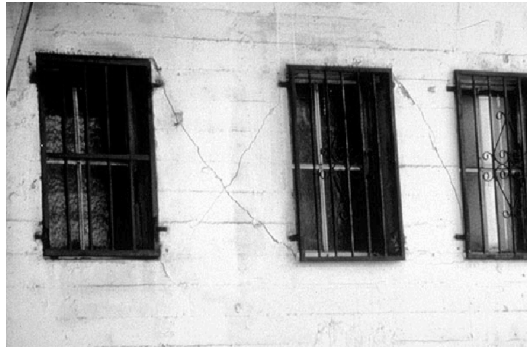
Fotografía 4-4. Elemento estructural sometido a tensiones de rotura
