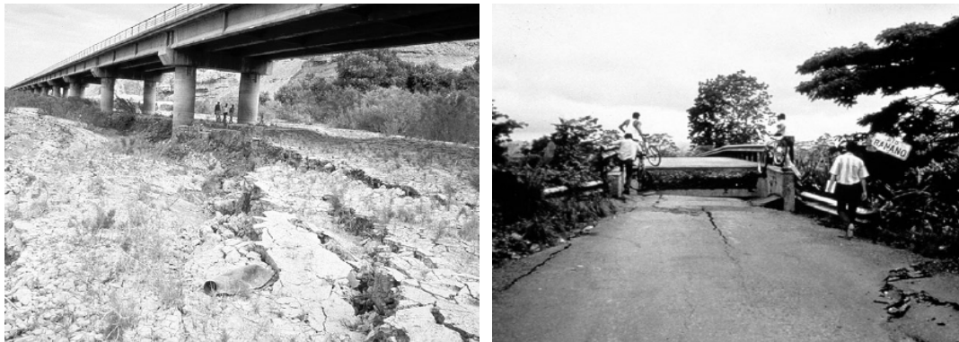
Figura 5-10. Fenómeno de subsistencia que provoca asentamiento de puentes y vías
